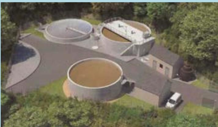
station à boues activées en aération prolongée avec épaissement des boues et stockage en silo dimensionné pour 1950 équivalent habitants. Ces équipements permettront de traiter, avec un niveau de qualité élevé jusqu'à 520 m<sup>3</sup>/j et 65 m<sup>3</sup>/h en pointe.
